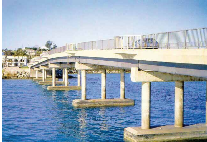
Los 12 puentes de Bermudas utilizan exclusivamente barras de refuerzo galvanizadas
