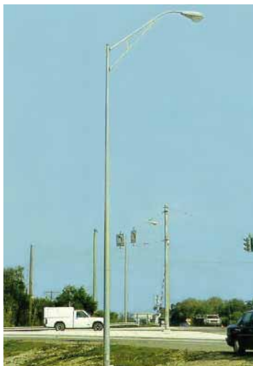
Postes de alumbrado galvanizado
