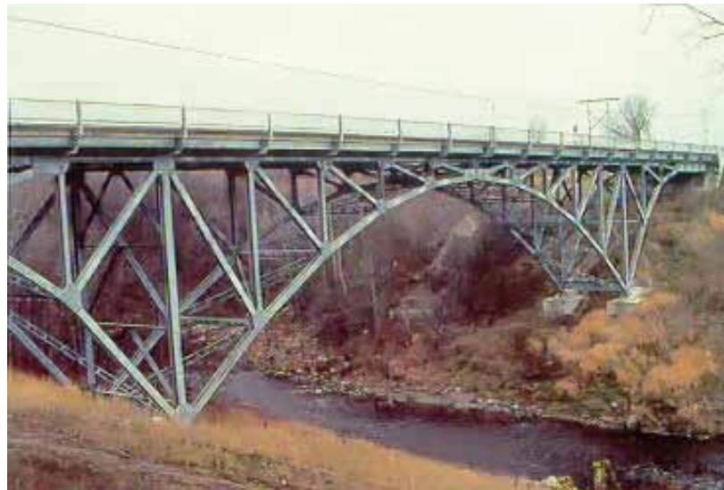
Puente Lizotte, Quebec, Canadá
