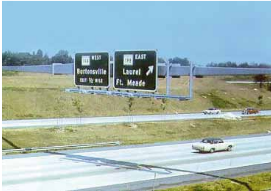
Estructuras galvanizadas de señales
