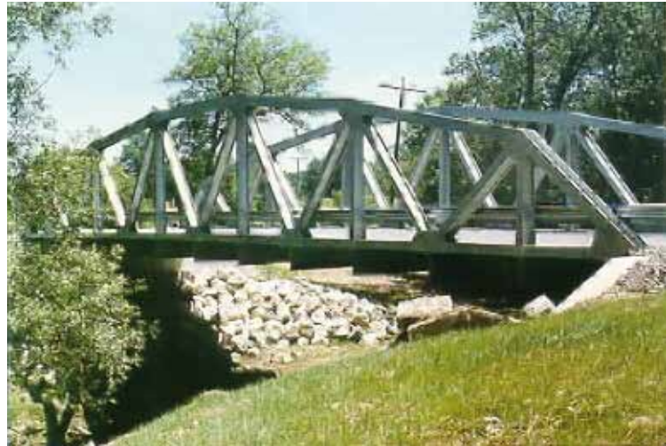
Puente del Camino Montgomery, Condado de Ashtabula, Ohio
