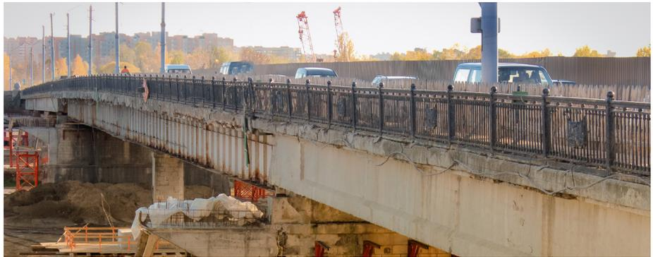
Las barras de acero de refuerzo descubiertas (o negras) dependen completamente de la protección brindada por el concreto circundante. Sin embargo, el concreto permite el paso de cloruros provenientes de sales de descongelamiento, sales marinas u otras sustancias corrosivas a la varilla debido a su permeabilidad natural, y también a través de rajaduras y juntas de expansión. Incluso el dióxido de carbono del aire, resultará eventualmente en corrosión de la varilla.
