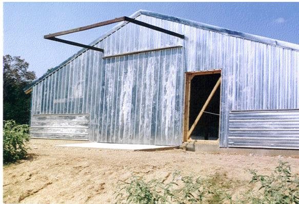
**Construcción levantada usando paneles galvanizados en forma de rollos con gran cantidad de corrosión blanca**
