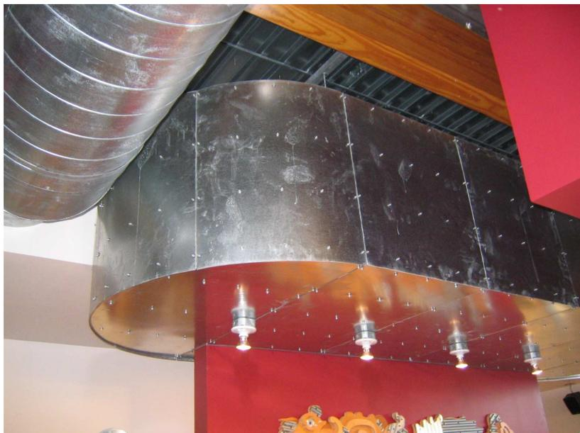
Figura 1 – Marcas de manipuleo y huellas dactilares en las instalaciones un ducto de acero galvanizado
