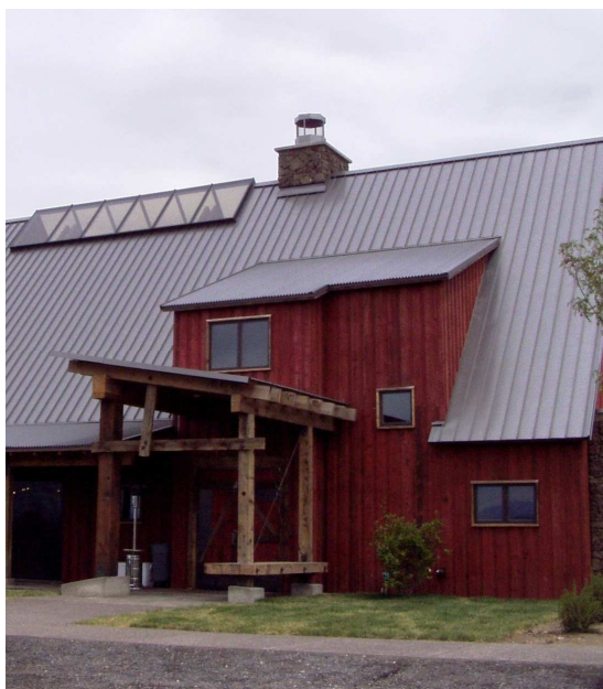
Figura 1 – Techo de acero bonderizado no pintado (cortesía de Steelscape Inc. )
